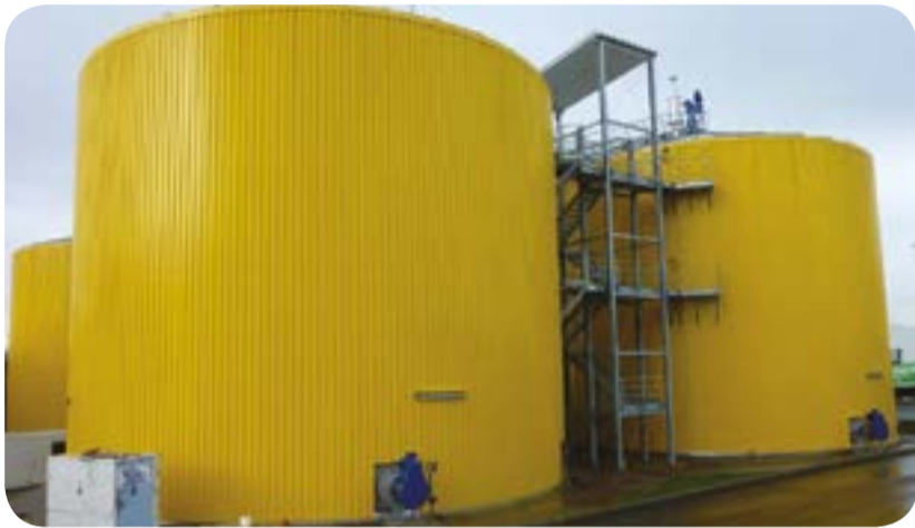
Digestori per biogas - Germania
